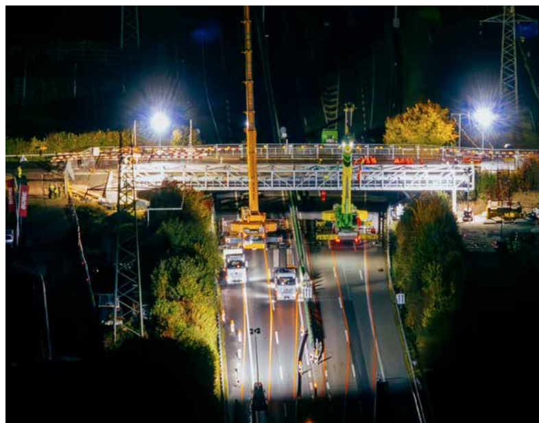
Nächtlicher Einhub der Rohrbrücke in Rotkreuz – ein Meilenstein für den Wärmeverbund Ennetsee.
